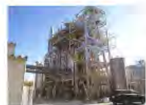
トラベリングストーカボイラー 燃料を密焼させ、蒸気を発生させます。
