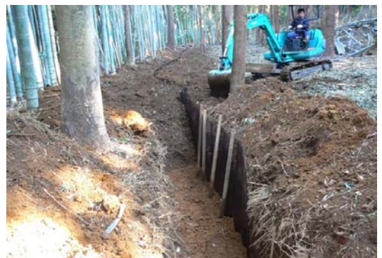
写真3 遮へい板を使った拡大防止
